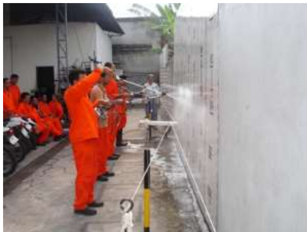
FIGURA 2 - Treinamento da técnica de borrifação em painel demarcado. Detalhe da posição das pernas do aplicador quando o inseticida é borrifado na parte inferior da parede.
